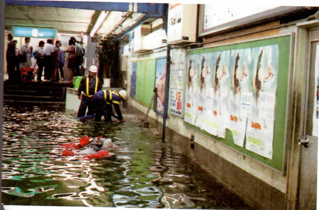
雨水が流れ込むJR品川駅地下通路
